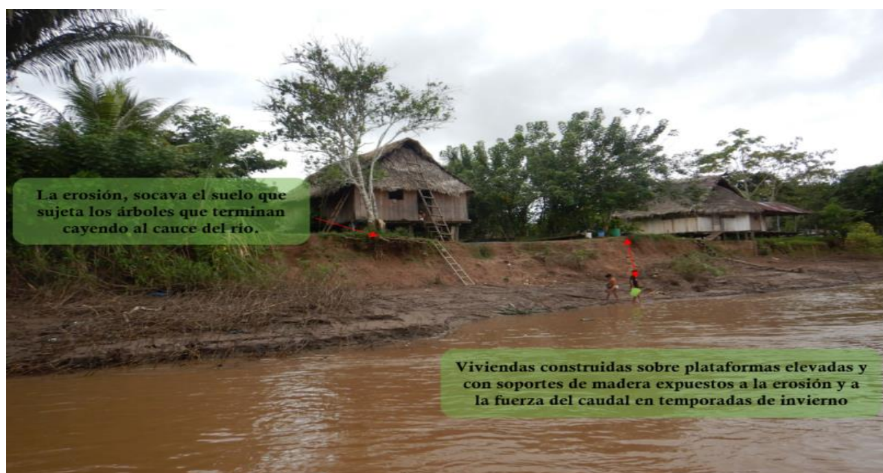
FIGURA N°05: VIVIENDAS EXPUESTA A EROSION, GENERADO POR EL INCREMENTO DEL CAUDAL
